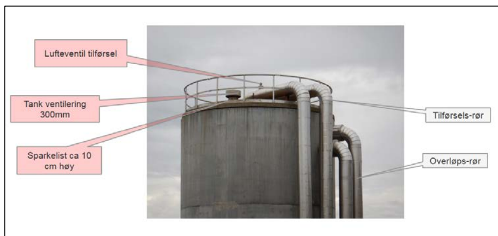
Figur 7-5 Bilde av toppen på H 2 S-reaktoren
