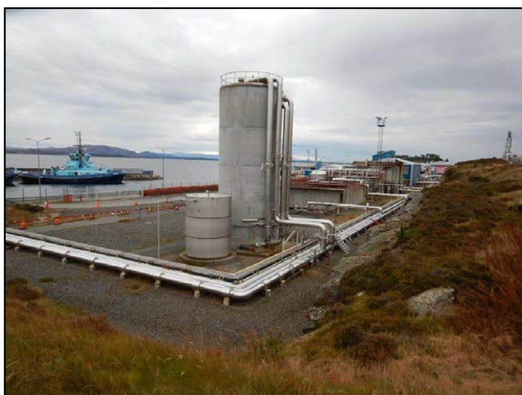
Figur 4-3 H 2 S-reaktoren på Sture
