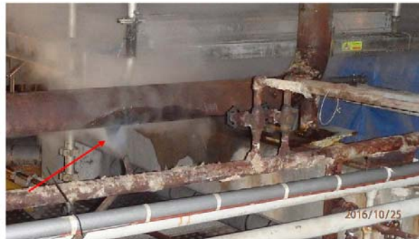
Foto fra Synergi nr. 1489103. Røret er normalt isolert.
